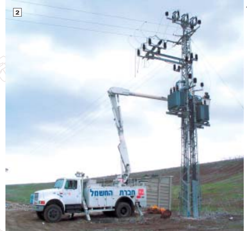
1-2. עבודות מיגון קו חשמל באזור קיבוץ רבדים. המיגון כאן נעשה לאחר שבקו הזה התחשמלו עשרות עופות דורסים, וביניהם מינים בסכנת הכחדה עולמית כמו עיטי שמש. עד כה מוגנו בישראל כ-2,400 עמודי חשמל, שהם רק אחוז קטן מאוד מאלה המפוזרים ברחבי ישראל, וממשיכים לגבות מחיר כבד הן העופות הדורסים והן מהמשק הישראלי כתוצאה מהפסקות חשמל ופגיעות במתקני חשמל.
