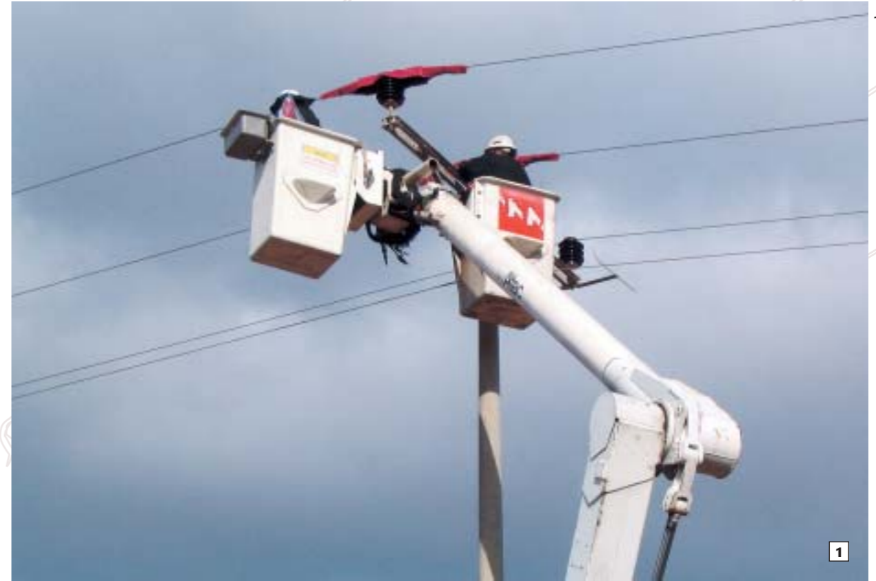
1-2. עבודות מיגון קו חשמל באזור קיבוץ רבדים. המיגון כאן נעשה לאחר שבקו הזה התחשמלו עשרות עופות דורסים, וביניהם מינים בסכנת הכחדה עולמית כמו עיטי שמש. עד כה מוגנו בישראל כ-2,400 עמודי חשמל, שהם רק אחוז קטן מאוד מאלה המפוזרים ברחבי ישראל, וממשיכים לגבות מחיר כבד הן העופות הדורסים והן מהמשק הישראלי כתוצאה מהפסקות חשמל ופגיעות במתקני חשמל.
